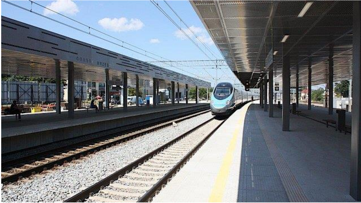
PERON KOLEJOWY WRZESZCZ
